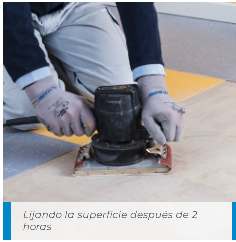
Regularizando la superficie a ras del sustrato
