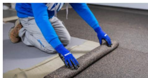
Extender los rollos de **Mapesonic CR** a lo largo de las superficies a revestir, prestando especial atención a alinear perfectamente un rollo al lado del otro
