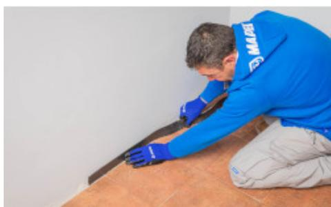
Aplicar la banda autoadhesiva **Mapesonic Strip** a lo largo del perímetro del local
