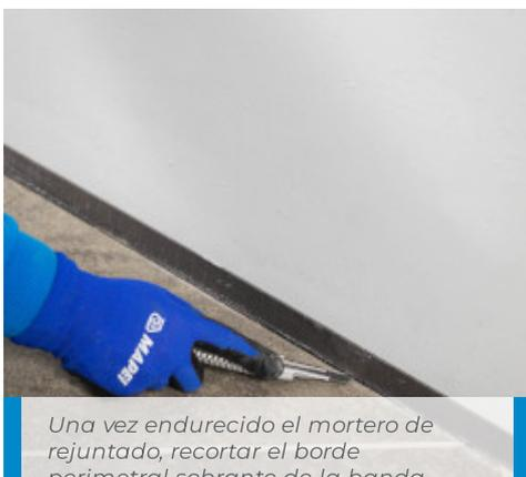
Una vez endurecido el mortero de rejuntado, recortar el borde perimetral sobrante de la banda Mapesonic Strip
