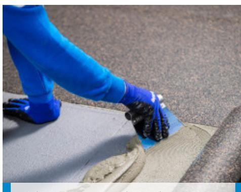
Sobre un soporte adecuadamente preparado, proceder a la aplicación del adhesivo para el encolado de la membrana fonoaislante.
