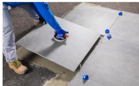
Extender el adhesivo sobre **Mapesonic CR** y proceder a la colocación del nuevo acabado del pavimento
