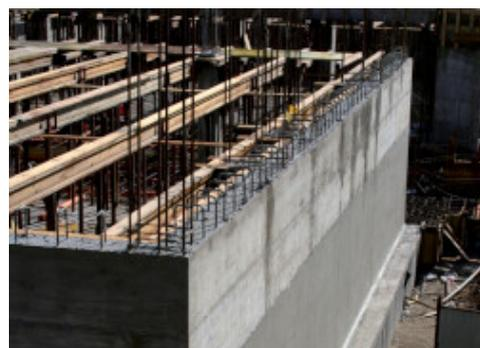
Muro de contención de tierras impermeabilizado después del hormigonado con **Mapelastic Foundation**
