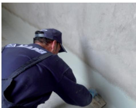
**Mapelastic Foundation** aplicado con llana, en una intervención de impermeabilización a contrapresión
