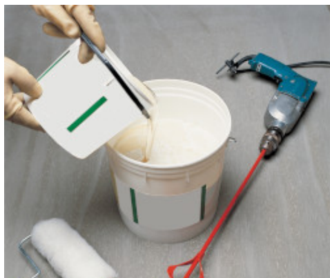
Mezclado del componente B con el componente A
