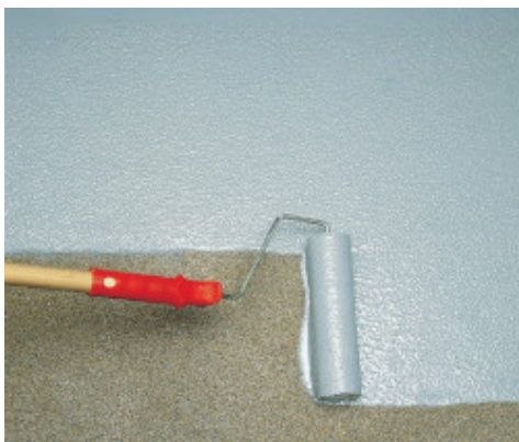
Aplicación de Mapecoat I 24 a rodillo
