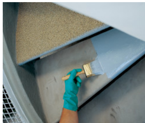
Aplicación de Mapecoat I 24 sobre hormigón
