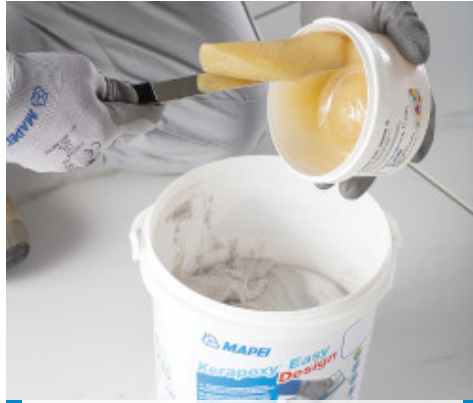
Verter el endurecedor (componente B) en el recipiente del componente A
