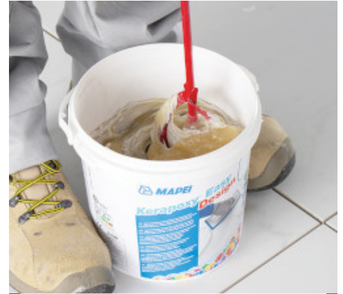
Mezclar los componentes (A+B)
