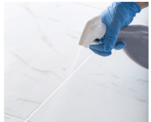
Posible limpieza final con UltraCare Kerapoxy Cleaner
