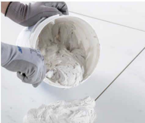
Obtener una mezcla homogénea cremosa
