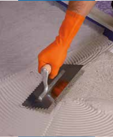
Aplicando una primera capa de Monolastic adherido con Mapetex Sel sobre un nuevo mortero
