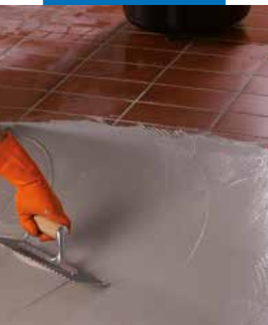
Aplicando una segunda capa de Monolastic sobre Mapenet 150
