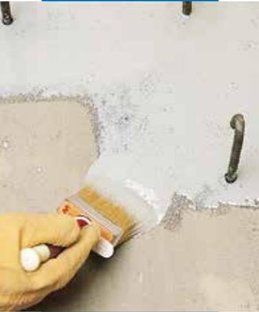
Aplicación de Eporip con brocha para puente de adherencia
