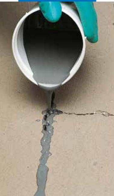
Reparación de grieta en recocado cementoso con Eporip
