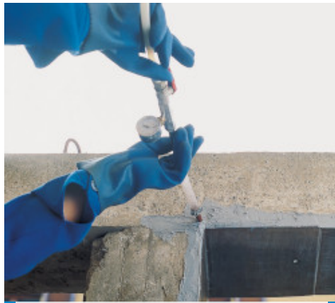
Viga placada con Adesilex PG1
