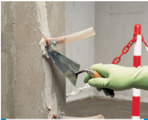
Fijación de tubos de inyección y estucado de las fisuras en consolidación estructural
