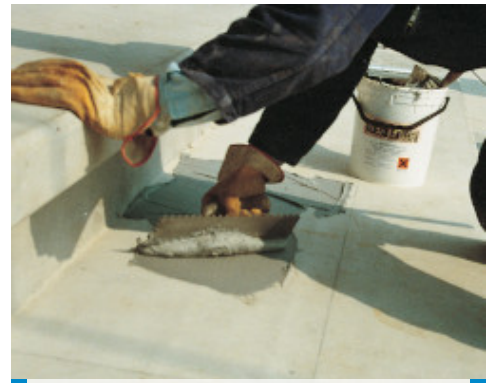
Aplicación mediante llana dentada de Adesilex PG1 para el encolado estructural de peldaños prefabricados
